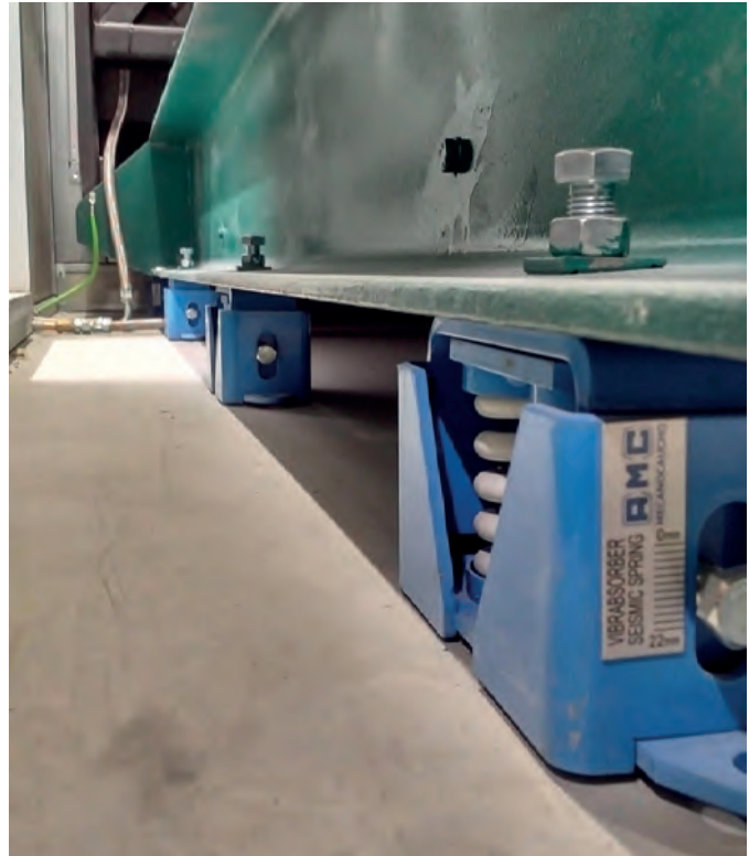
Compresseur isolé avec VIBRABSORBER + Sylomer®
