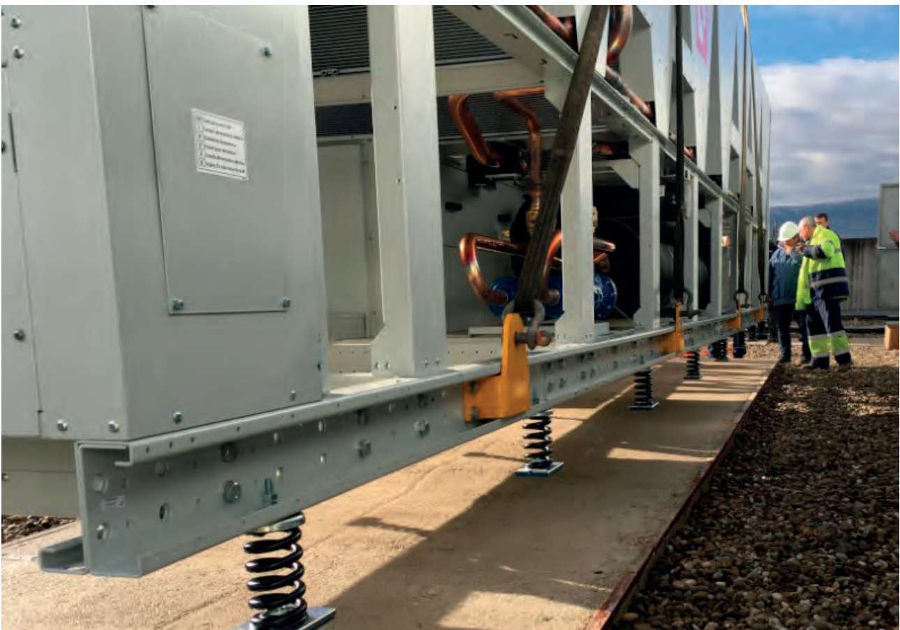
Groupe de froid isolé avec VIBRABSORBER + Sylomer®
