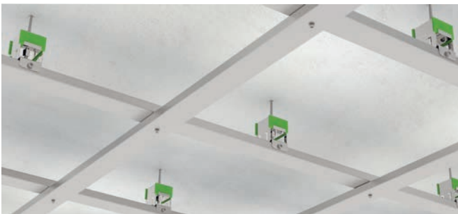
11.- Fix transverse profiles.
